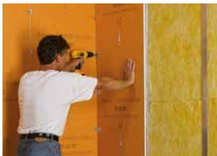
Schlüter-KERDI-BOARD pode-se aparafusar rápida e facilmente com os nossos parafusos a estruturas de madeira ou metálicas como suporte para a colocação de cerâmica.
