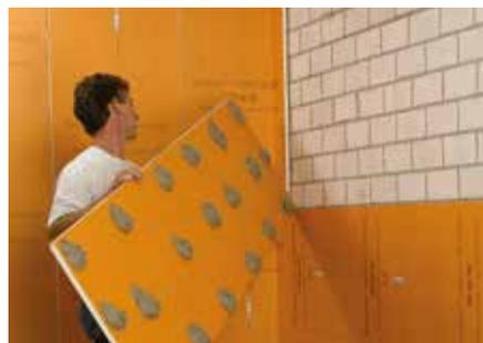
Dependendo da nivelção e do material do suporte existente, Schlüter-KERDI-BOARD, pode-se aderir em capa fina ou sobre pontos de cimento cola ao suporte, para uma colocação alinhada.
