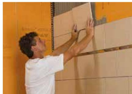
O suporte para a aplicação de cerâmica, através de cimento cola, deve estar completamente plano e ser resistente à humidade.
